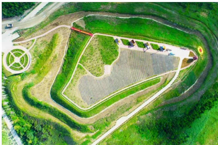
图3-1-11 铜山矿区原排土场生态恢复措施示意图（现为矿山设备公园）
