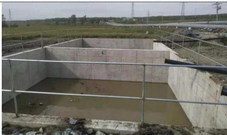
2 座 300m 3 事故池
