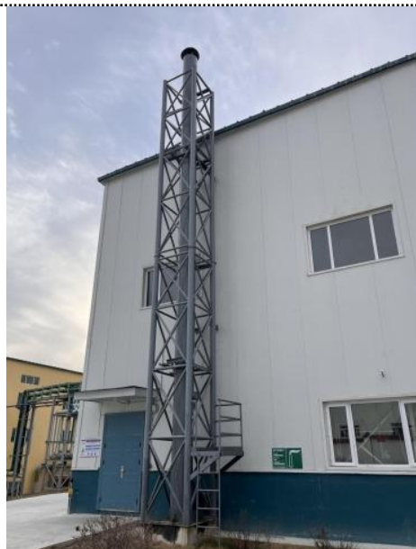
原料车间排气筒
