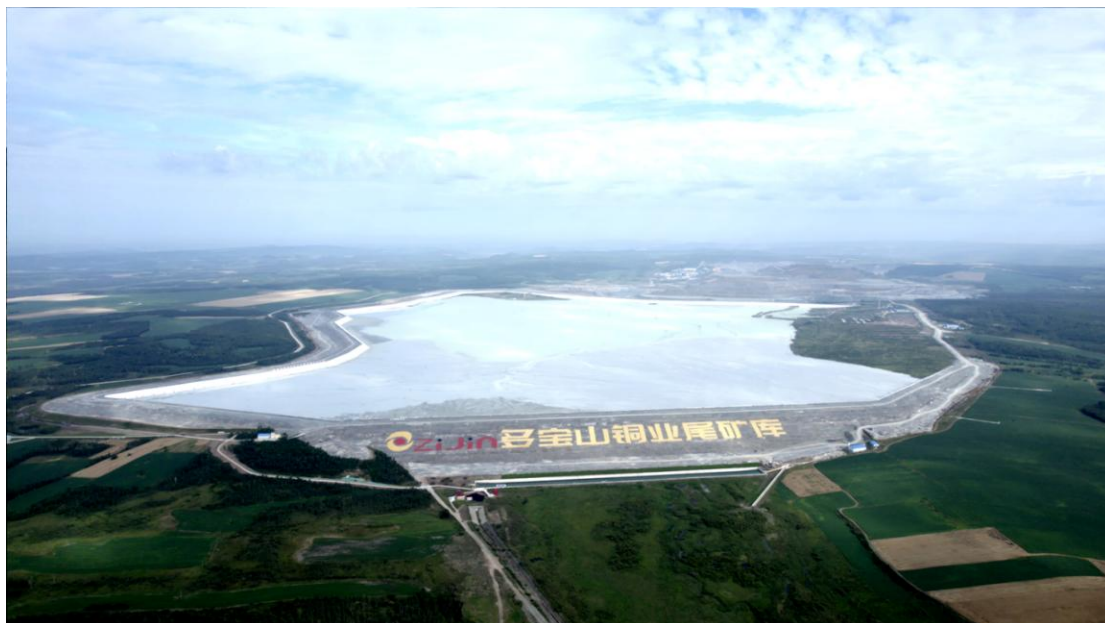
尾矿库现状照片
