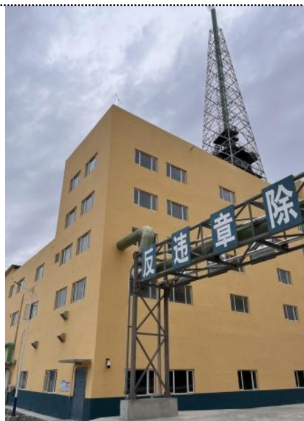
回转窑废气排气筒
